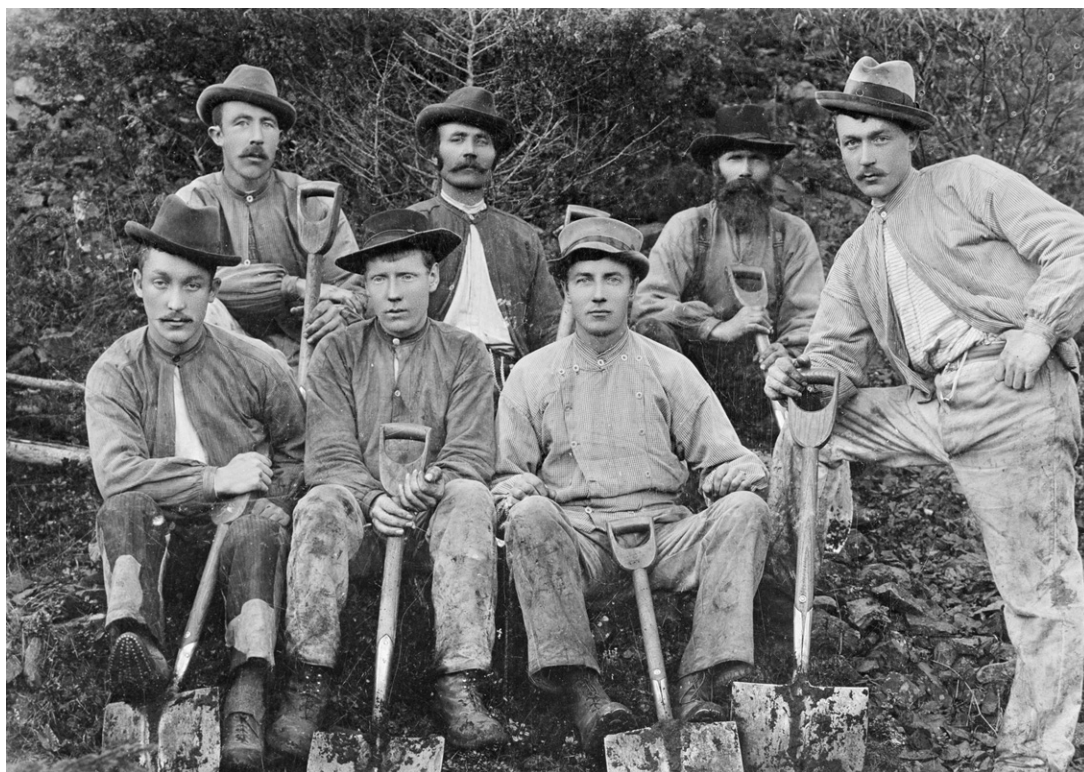
Anleggsarbeidere på Hamar-Selbanen, ca. 1895. Ukjent fotograf
