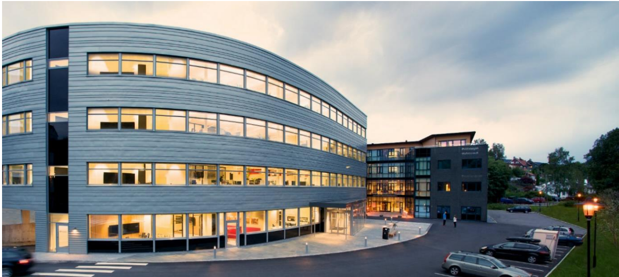
Bergens første BREEAM-NOR Excellent-bygg (Nesttunbrekka 99)
