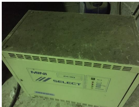
Bilde 34: Mangel på vedlikehold av trucklader.
