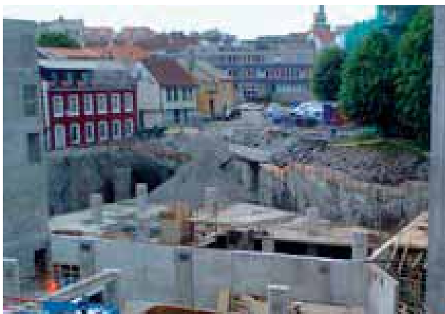
Et nytt mediehus under bygging i Stavanger. mmsfoto: Ragnhild Kr. Olsen
